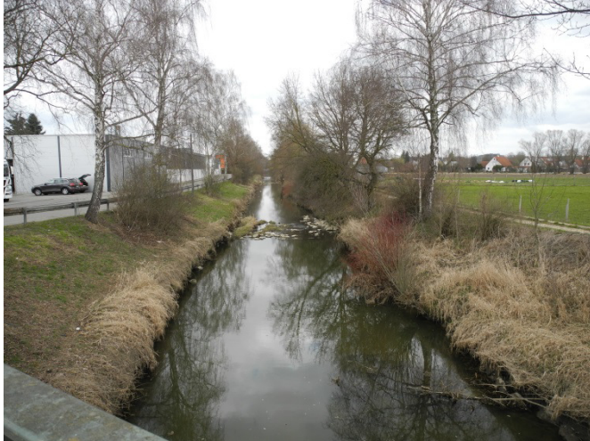
Abb. 5: Zusamkanal in Wertingen dient der Hochwasserentlastung und führt nur eine geringe Restwassermenge
