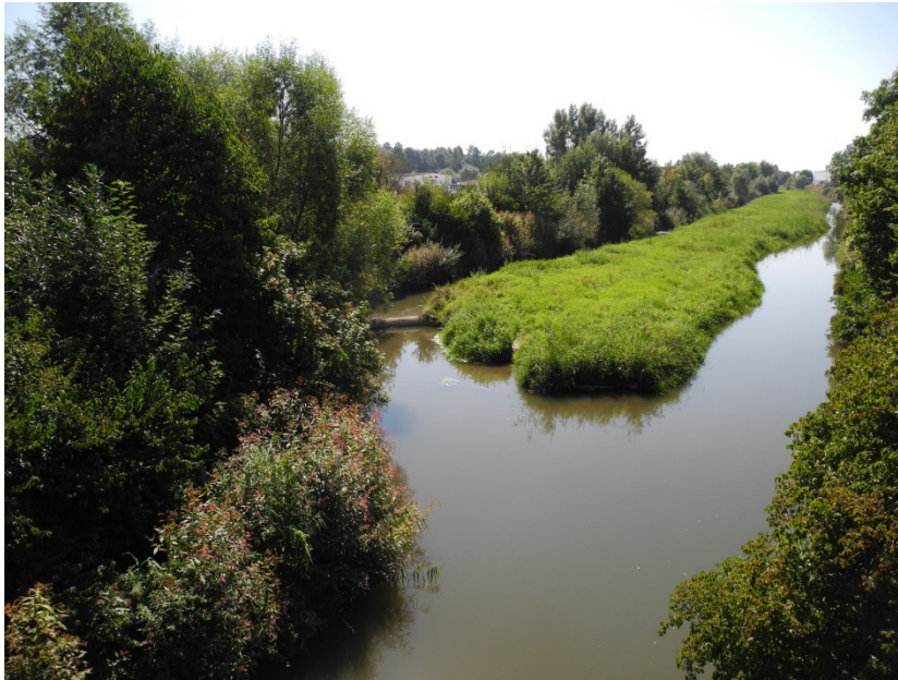
Abb. 8: Blick von der Umgehungsstraße Pfaffenhofen-Gremheim: rechts Zusam, links Seitenarm mit Kanalquerung
